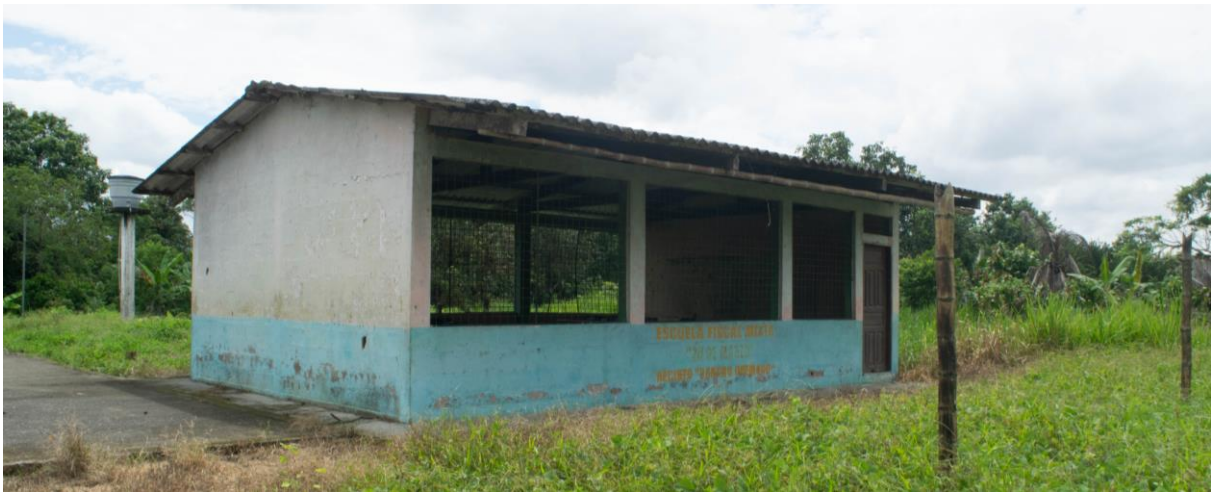
FOTOGRAFÍA 8. Escuela 20 de Marzo, sin funcionamiento.
