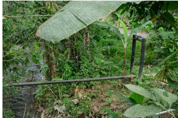
FOTOGRAFÍA 11. Tubería en el puente del Río Agua Clara
